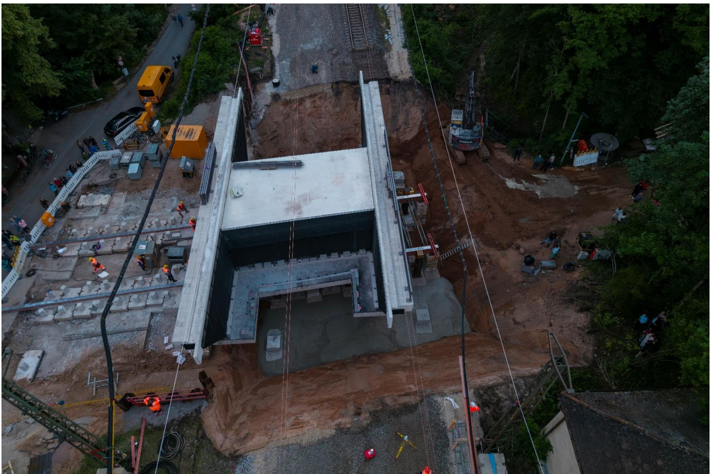
Monika Rösler - Die neue Brücke Ist fast in endgültiger Lage
