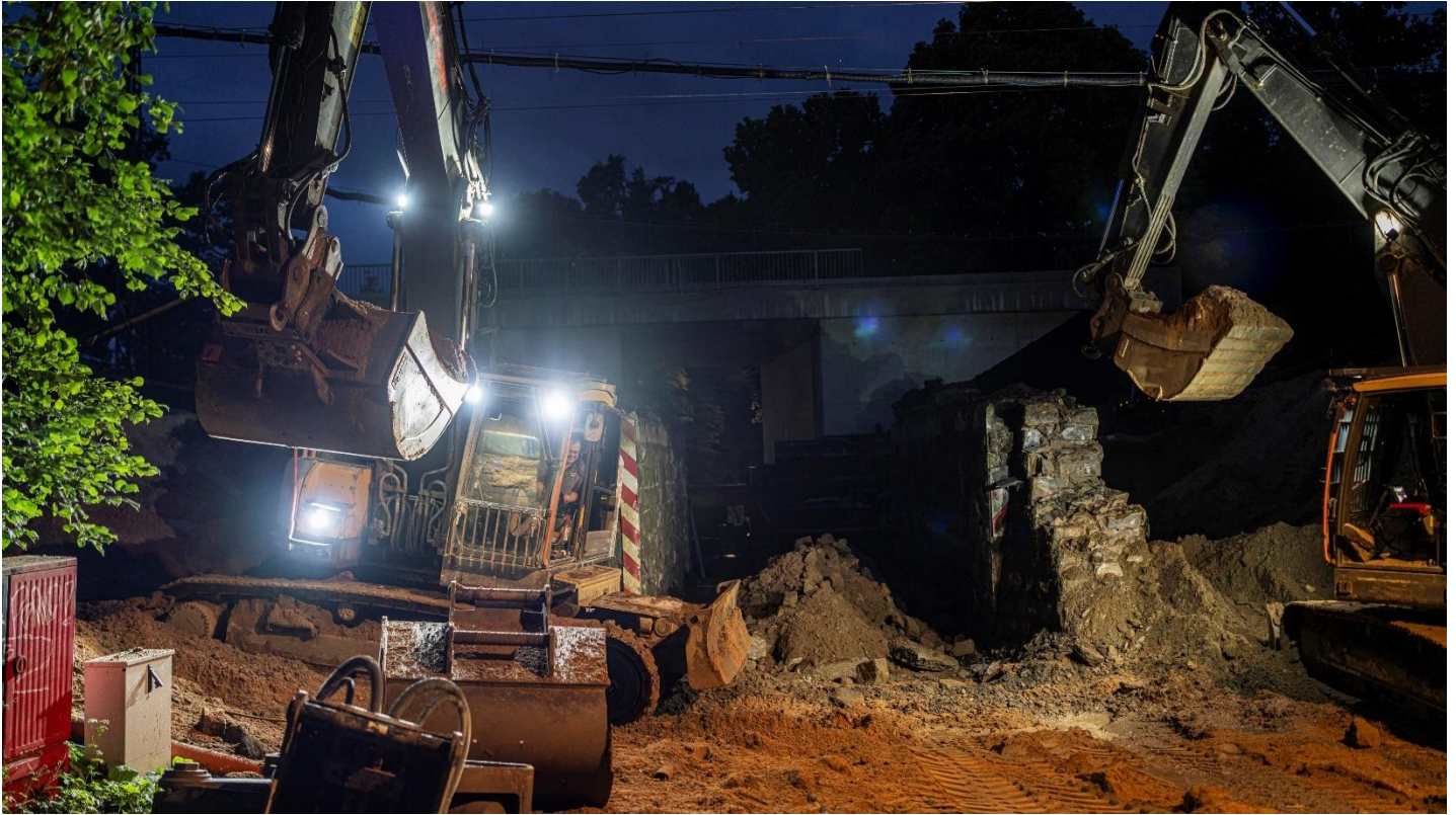
Horst Badewitz - Abbruch der alten Bahnbrücke
