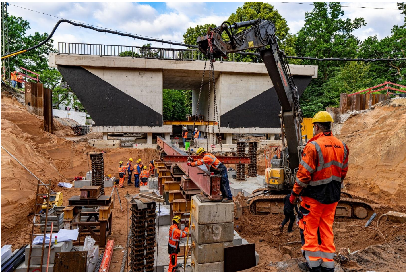
Horst Badewitz - Montage der Verschubbahn
